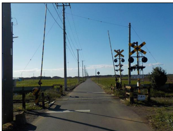
磯崎第2踏切 施工前
