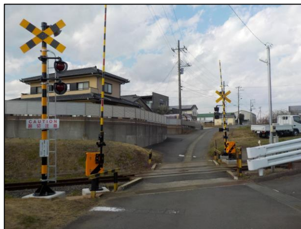
平磯第2踏切 施工後
