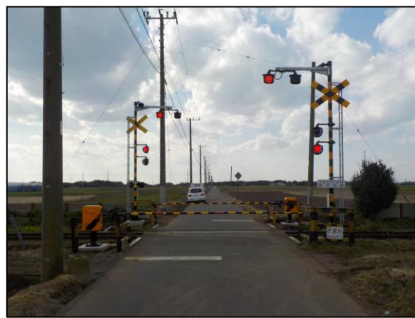
磯崎第2踏切 施工後
